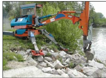
10.41–10.45. kep: Mini vízerőmű a Nyitra folyón, partfal karbantartása
