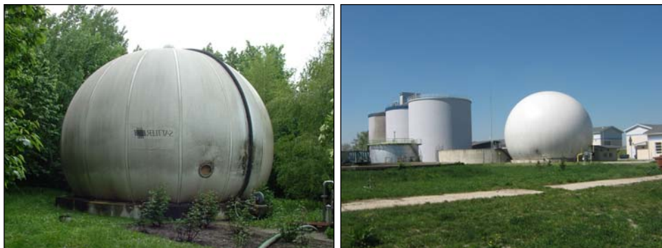
10.12–10.13. kép: Szennyvíztisztítók gáztározói
