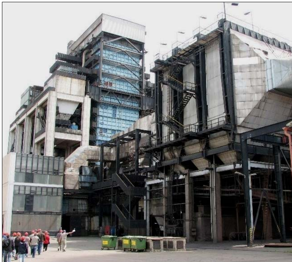
10.1. kép: Erőművi blokk: kazán, szénőrlő malom
