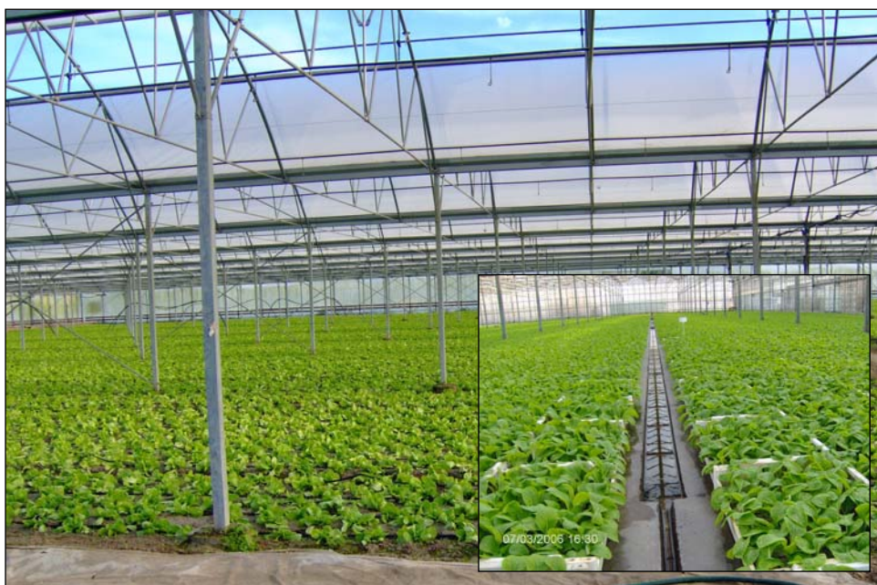
9.2. kép: Üvegház energia ellátása és felhasználása
